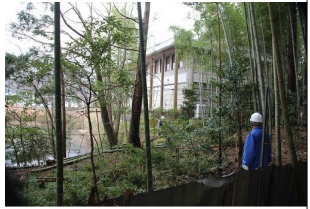
[2月15日] 水分れ資料館の際の竹林と藪を除間伐し、池周辺の美しい景観の再生に取り組む様子。
