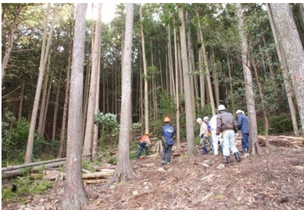
[1月18日] 千代田池左岸での除間伐作業風景。大きくなりすぎた木の伐倒は、無理をせず、技術を持った外部からの応援を得て実施。
